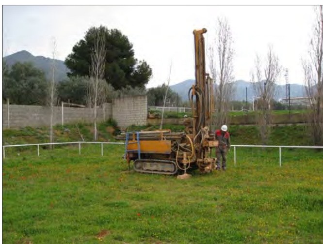
Execució dels sondeigs S-6 i vista general del solar.
