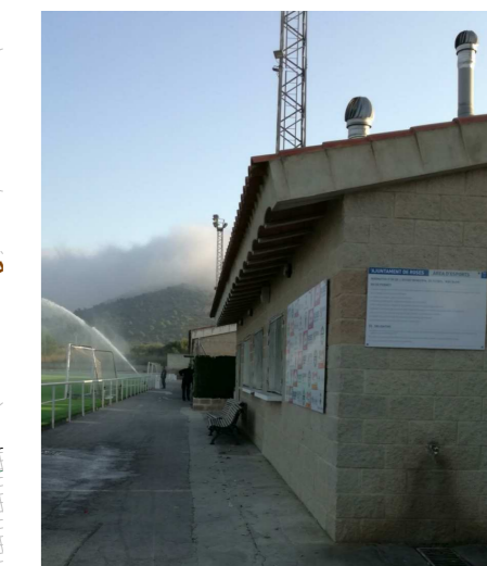
3. Edifici a enderrocar
