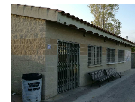
2. Edifici a enderrocar
