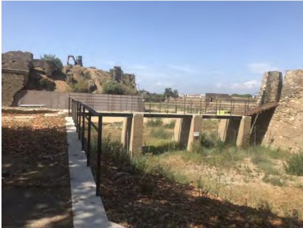
Pont peatonal rec d'en Forquilla
