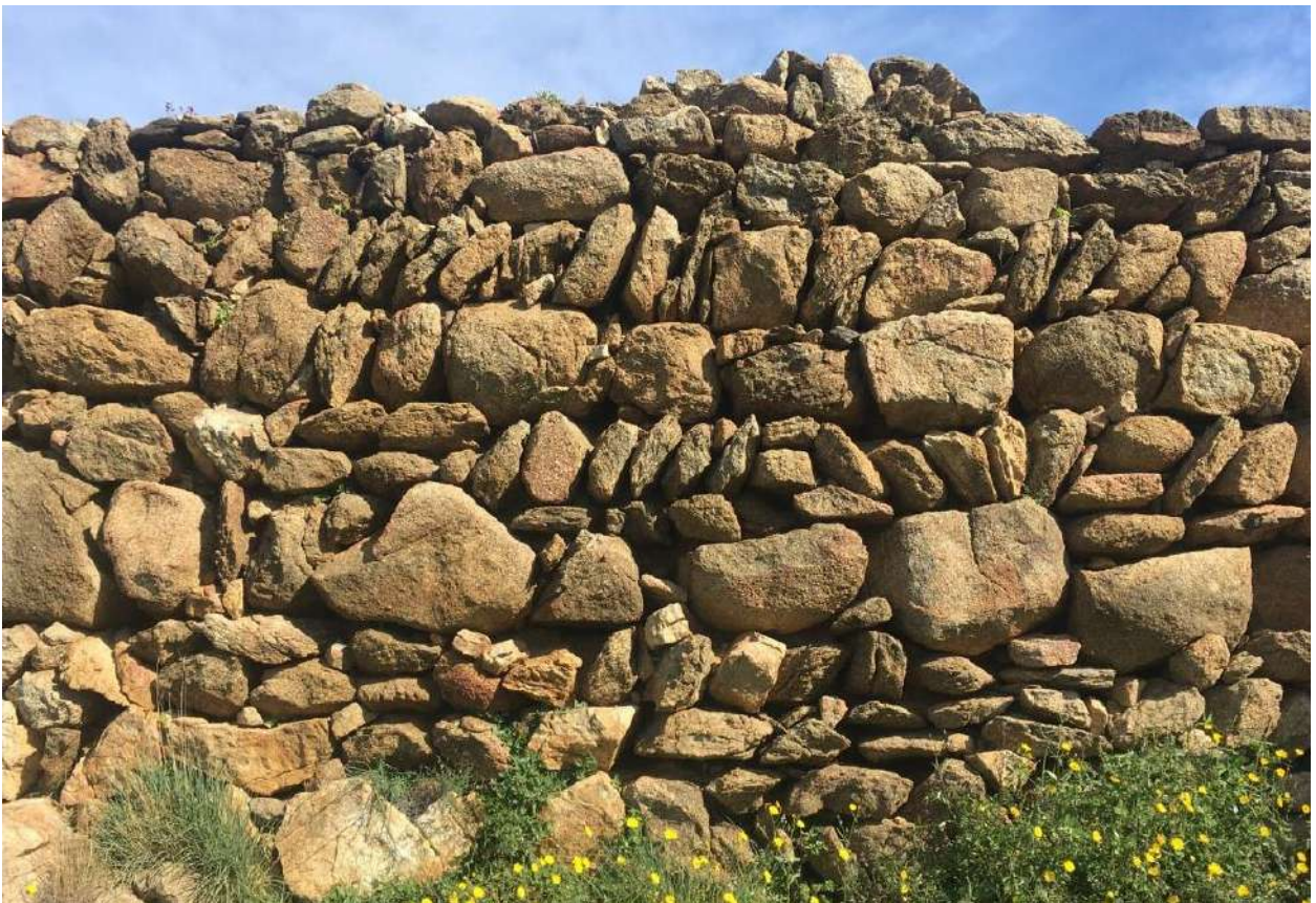
Fig. 10 - La disposició característica "en llibret" inspira la forma de la peça prefabricada de formigó utilitzada en la definició del projecte. 19/02/2020
