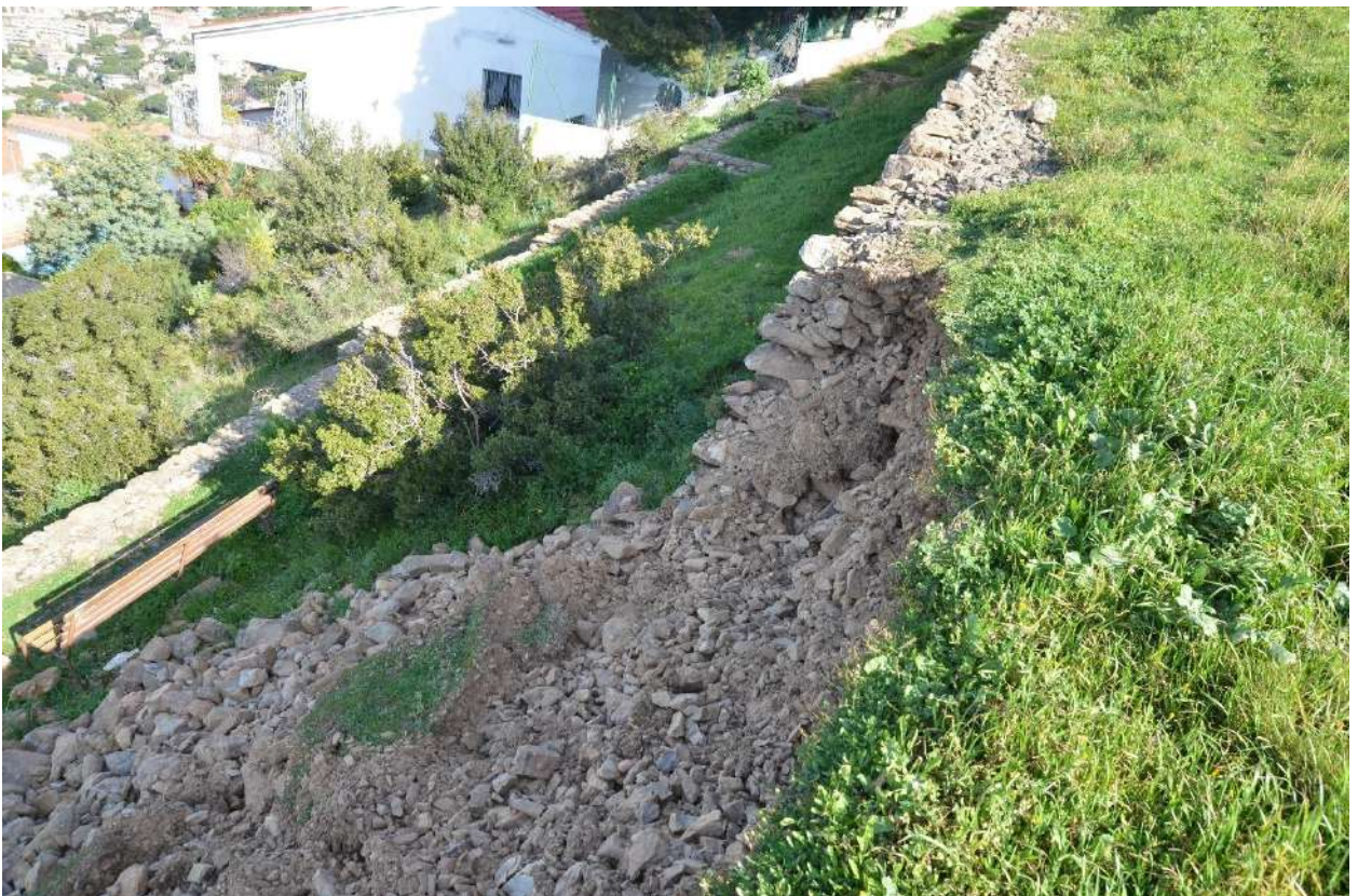
Fig. 06 - Meitat i extrem drets de l'esvoranc produït pel col·lapse, vistos des de la plataforma superior del terreny. 19/02/2020
