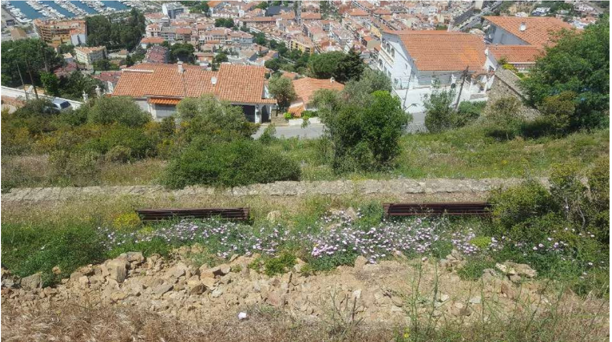
Fig. 11 - Runa del col·lapse vista des de la part superior del mateix. Arriba fins al mobiliari urbà, situat en el límit entre el talús i el camí de ronda, contingut per un altre mur. 26/05/2021
