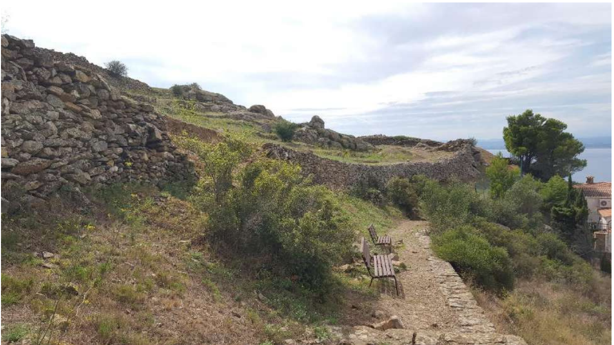
Fig. 16 - Àmbit a intervenir vist des d'una cota superior, pujant el primer tram de graons del camí de ronda. 22/09/2021
