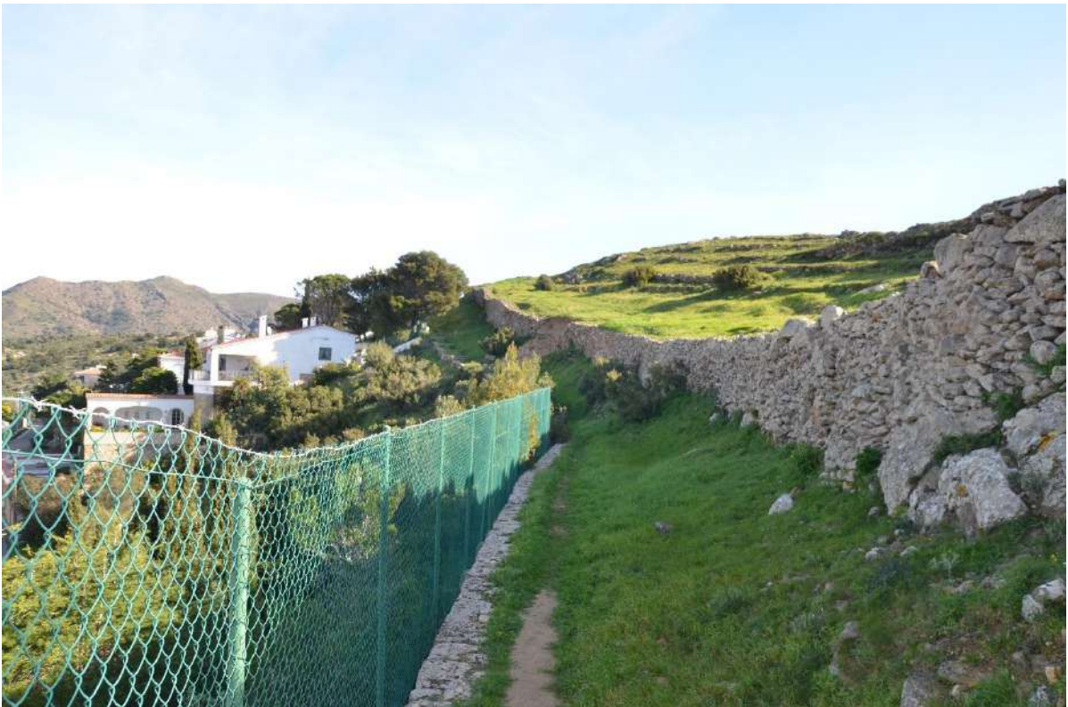
Fig. 02 - Marge i col·lapse des del camí de ronda i el talús que voregen el perímetre de la muralla. 19/02/2020
