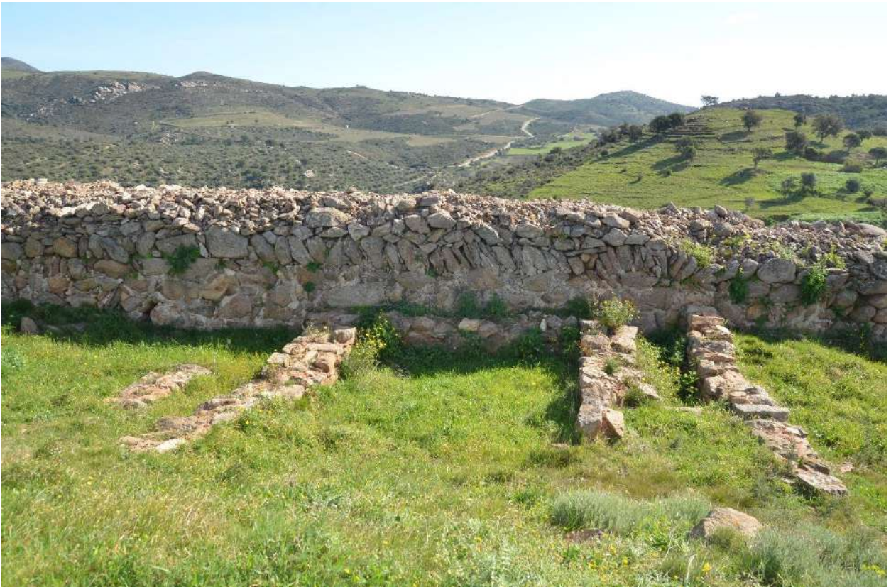
Fig. 08 - Pany de muralla visigòtica restaurada situada al sector est del turó. S'hi observa la disposició "en llibret" de la fàbrica de pedra. 19/02/2020
