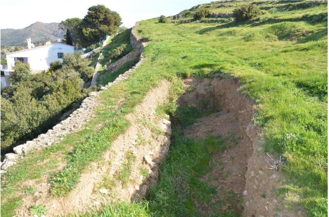
Fig. 07 - En primer pla, excavació arqueològica per determinar el traçat de la muralla visigòtica. A la part inferior de la paret esquerra s'hi observa la hipotètica muralla. En relació a aquest fet, es desenvolupa el projecte considerant que la muralla transcorre paral·lela i a poca distància del marge col·lapsat, situat al fons de la imatge. 19/02/2020
