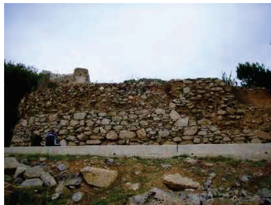
Fig.24. Vista de l'hort i el mal estat de conservació del mur U.E.128 (Font: invarquit gencat- foto de Jacob Casquete-2008)
