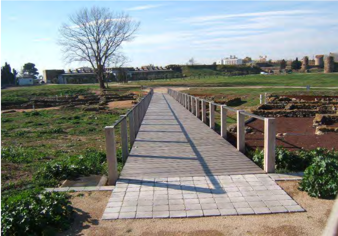
Barri hel·lenístic, passera de suports de posts de fusta, acer pintat gris antracita i paviment de llatges de fusta
