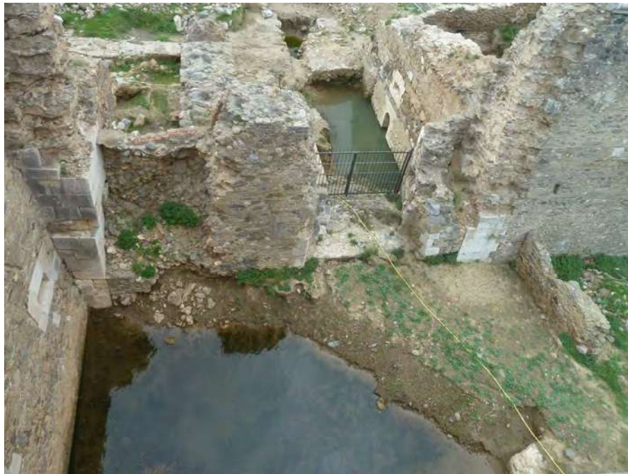
Figura 5: Porta de Terra en procés d'excavació. S'hi pot observar com del portal original només es féu l'encastament en pedra calcària dels laterals, mentre la resta de l'obra mai fou bastida, la qual cosa obligà a fer un seguit de pedaços que permetessin posar-la en condicions de defensa.
