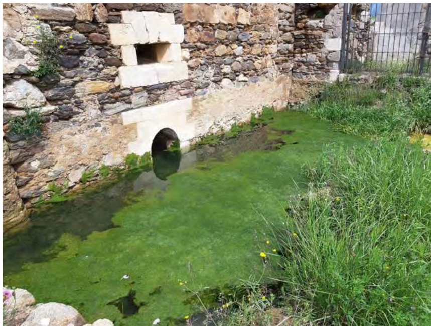
Figura 6: Porta d'accés al cos de guàrdia original, aquest element mai estigué en funcionament i fou ràpidament amortitzat. No obstant això, ens permet observar com el nivell d'accés des del fossat al pati d'armes era més de dos metres inferior a l'actual.
