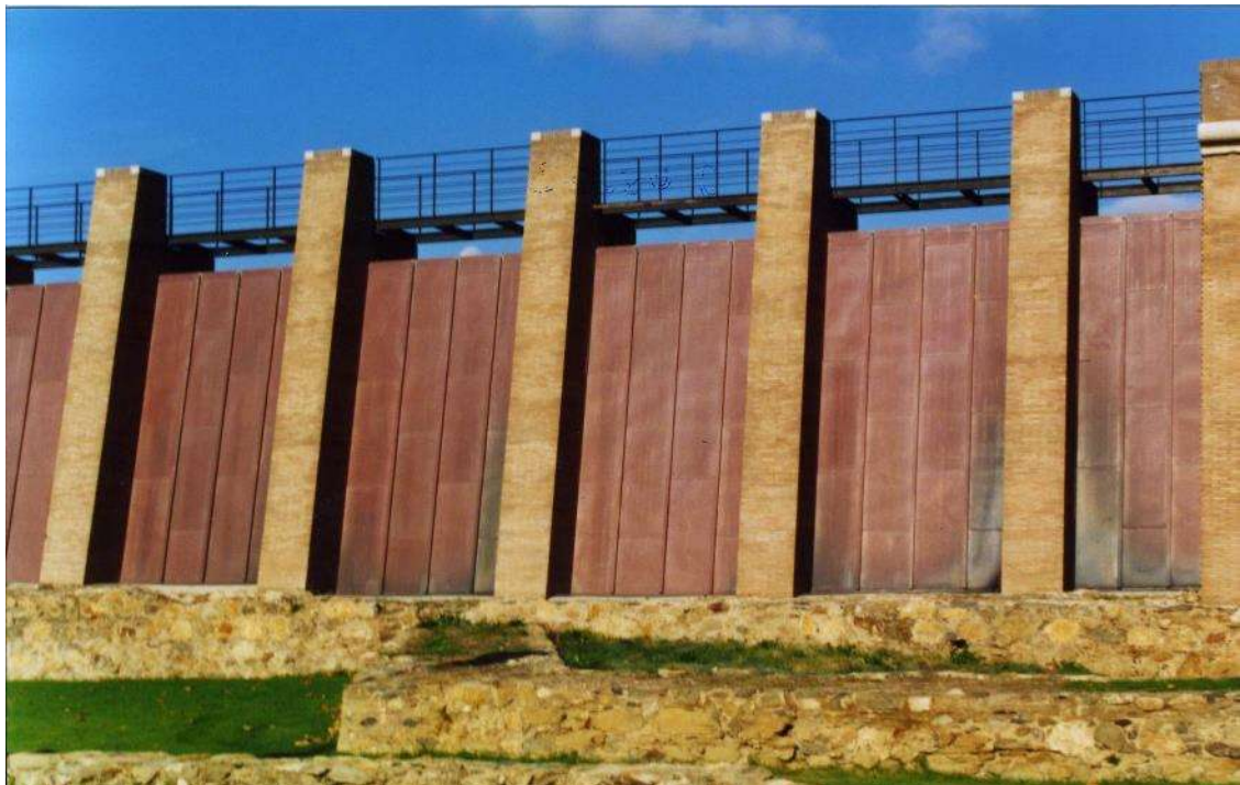
Edifici de serveis (fotografia 2000)
