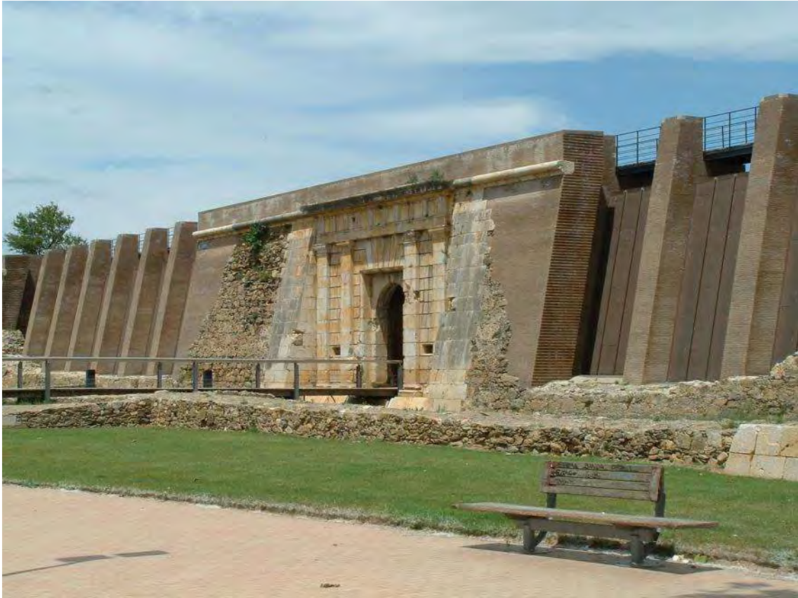
Porta de Mar, amb la barana del pas de ronda, i la passera d'accés amb tubular d'inoxidable i cablejat horitzontal
