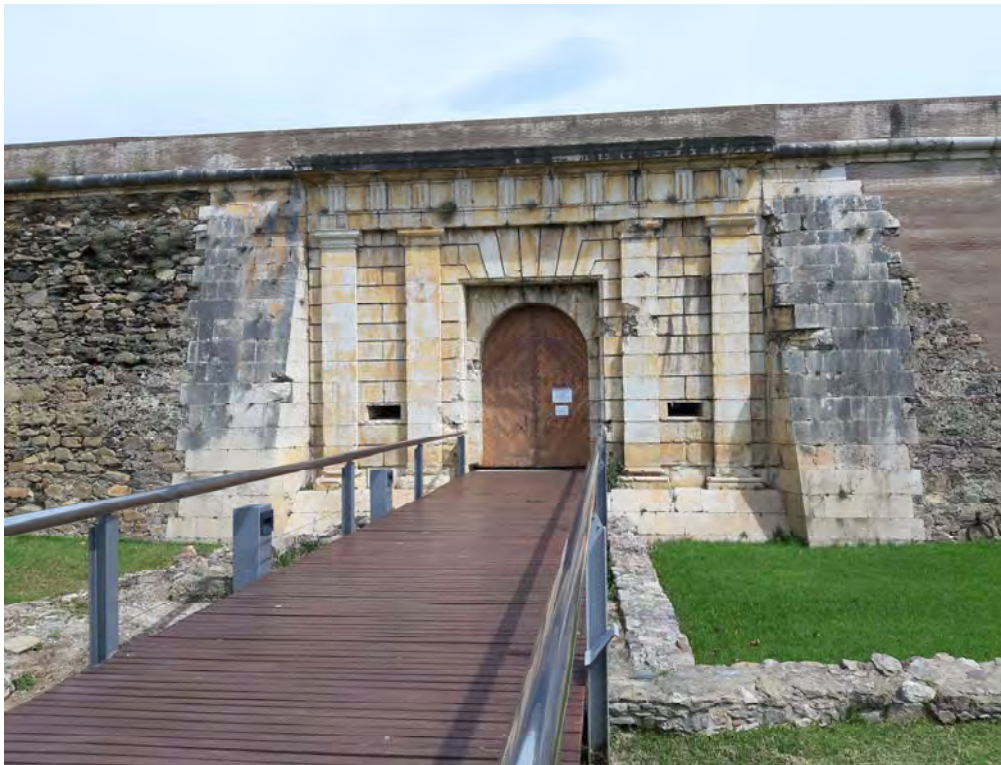
Figura 4: Porta de Mar de la Plaça Forta de Roses. Es tracta d'un portal de carreus bastit a imitació de l'arquitectura clàssica, en estil dòric. La necessitat d'encabir-hi dues troneres laterals per a falconet –petits canons de retrocàrrega– impedié fer-hi un triple portal.
