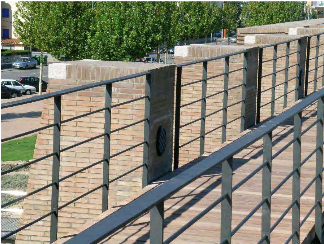
Barana de la porta de Mar amb presència del passamà horitzontal i els muntants verticals, d'acer pintat color gris antracita, i paviment de llatges de fusta (1997)
