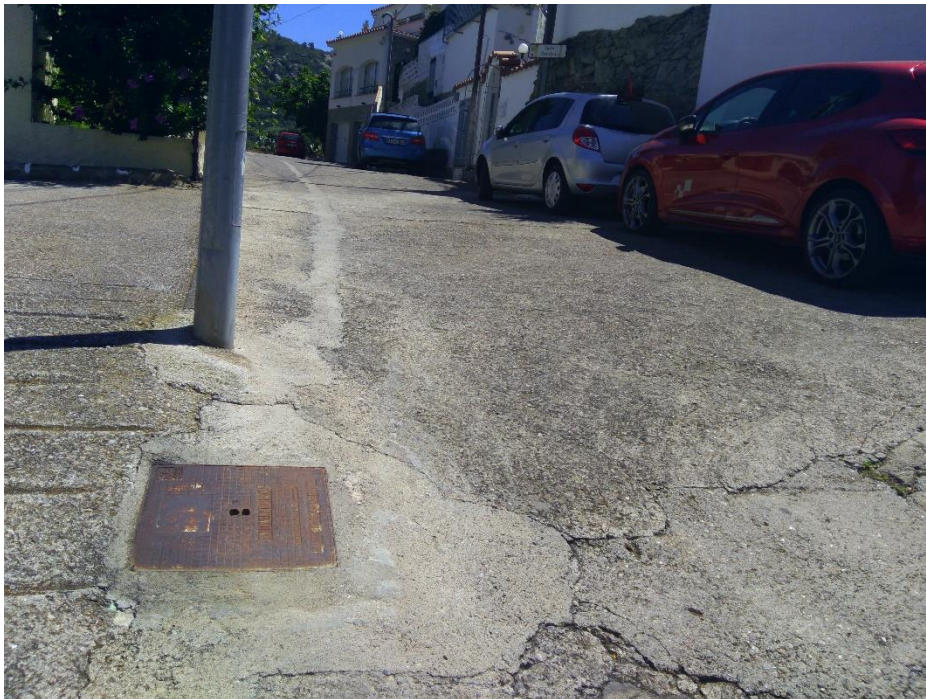
Figura 38. Tram de carrer Tordera amb capa de rodament actual de formigó
