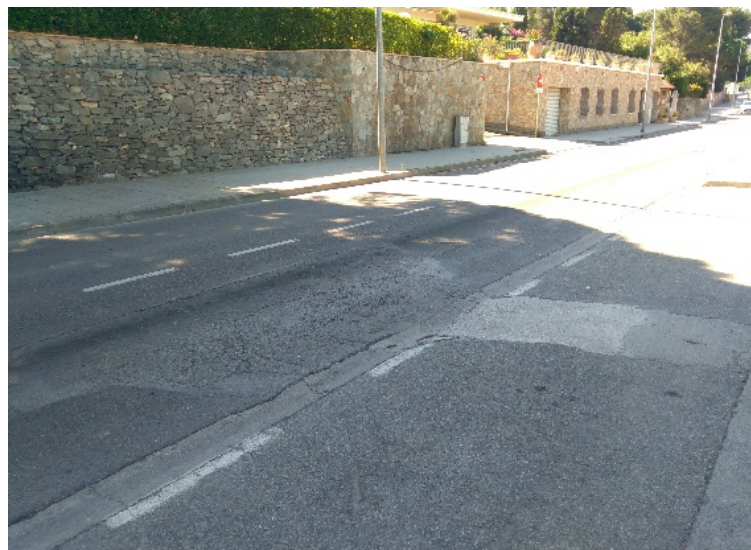
Figura 4. Presència de flonjalls
