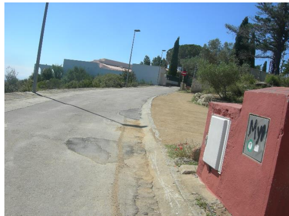
Figura 27. Estat actual de la capa de rodament
