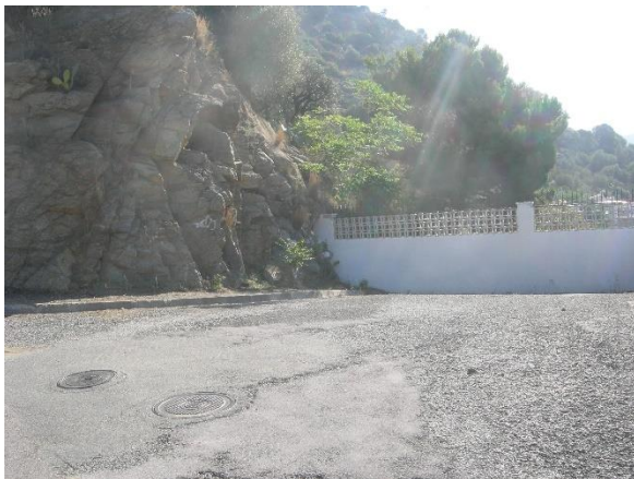
Figura 19. Trencament de la capa de rodament
