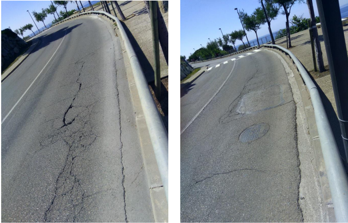
Figura 8. Ferm amb pell de cocodril i flonjalls
