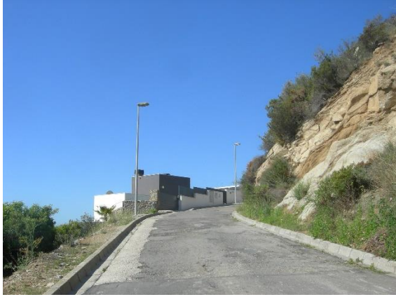
Figura 23. Reparacions puntuals de la capa de rodament
