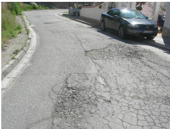
Figura 24. Presència de flonjalls i pell de cocodril
