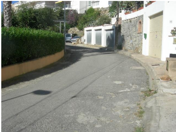
Figura 20. Reparacions parcials i estat inicial de deteriorament de la capa de rodament
