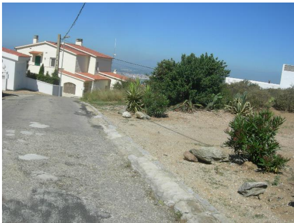
Figura 27. Estat actual de la capa de rodament
