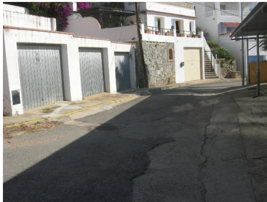
Figura 20. Reparacions parcials i estat inicial de deteriorament de la capa de rodament
