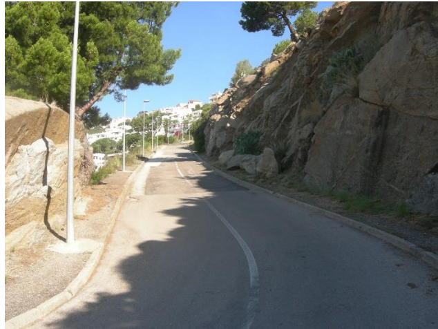
Figura 18. Presència de reparacions parcials
