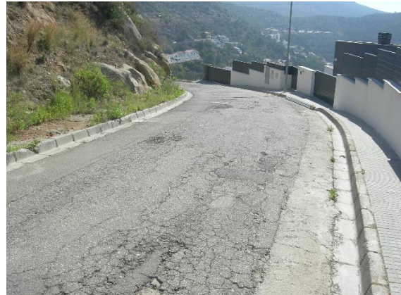
Figura 24. Presència de flonjalls i pell de cocodril
