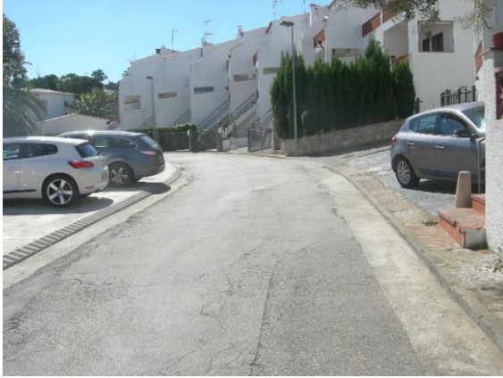
Figura 29. Estat actual de la capa de rodament
