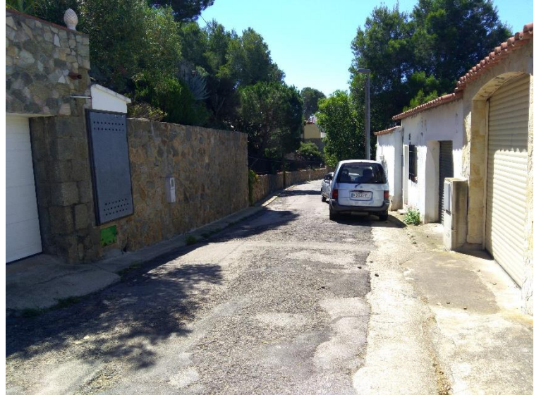
Figura 33. Estat actual de la capa de rodament
