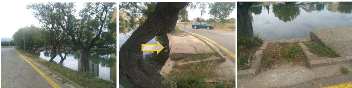
Figura 4. Arbres i vegetació. Canonades protegides amb formigó. Zona de desguàs.
