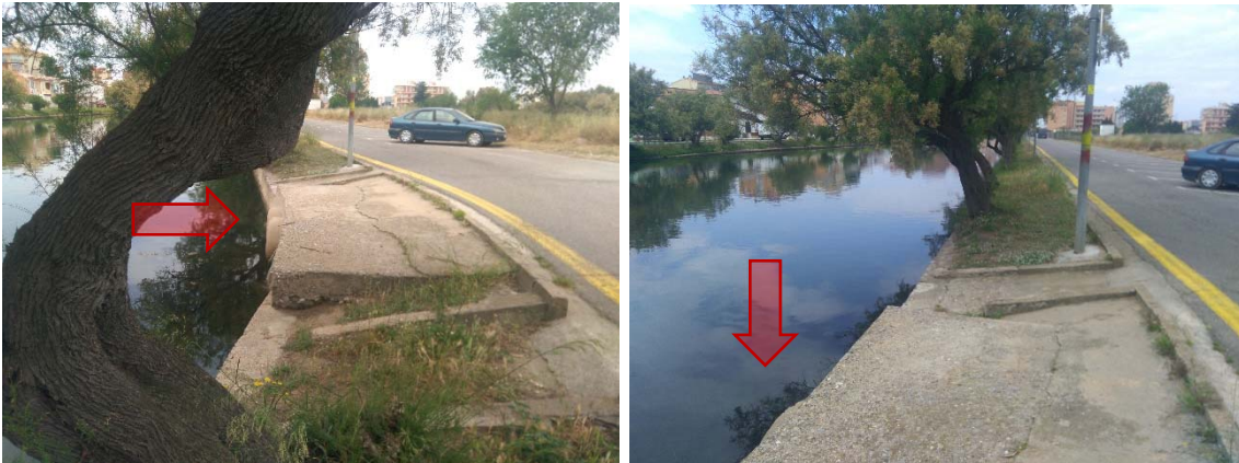
Figura 5. Canonades subterrànies, formigonat superior
