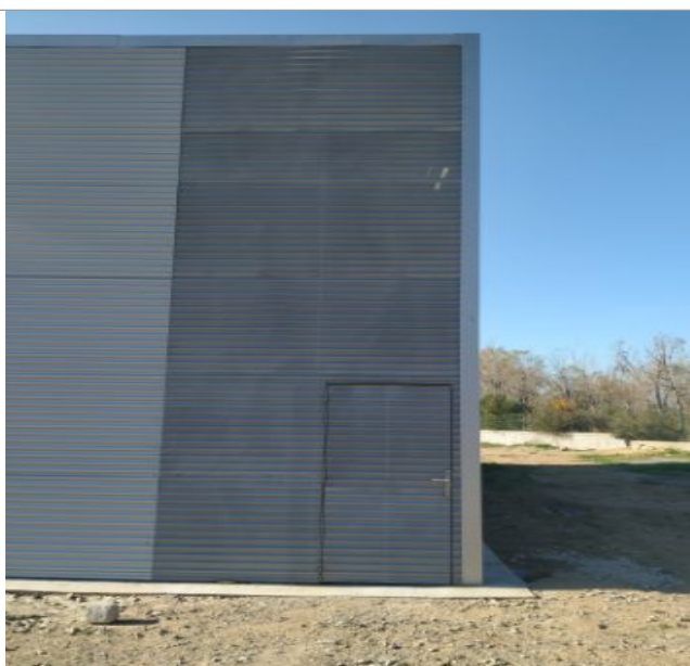
Figura 9.- Revestiment exterior ondulat actual amb perfil de xapa «miniona» cega i perforada.
