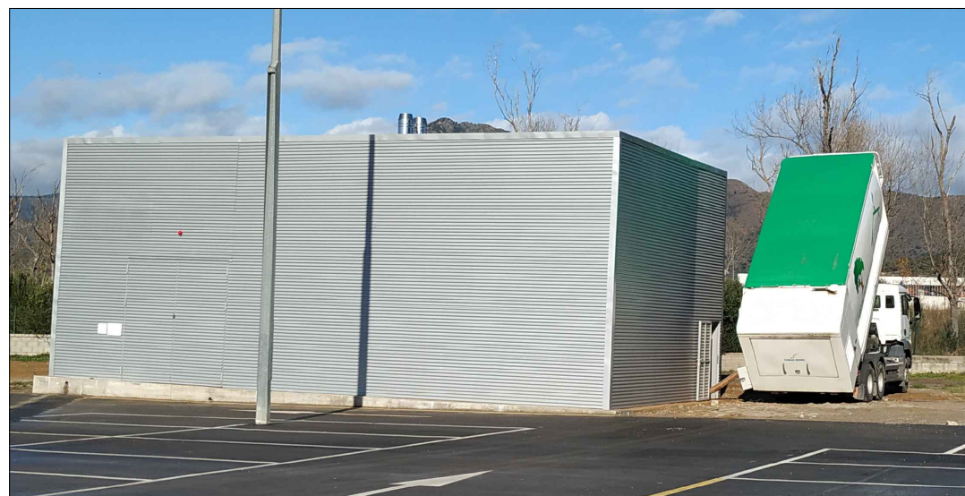
Imatge 1.- Camió realitzant la descàrrega
