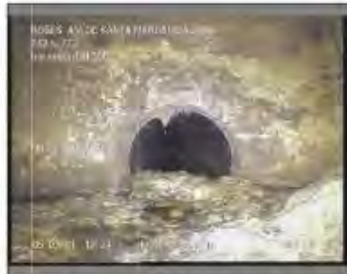
Foto: 60_1_8_05032021_122640_A.JPG 27,9m, Fin de la Inspección
