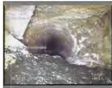
Foto: E_1_7_18022021_131156_B.JPG 13,9m, Inspección interrumpida
