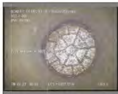
Foto: 11_1_3_28022021_101141_B.JPG 23,3m, Pozo Intermedio
