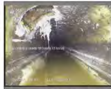
Foto: 1_1_E_18022021_104817_A.JPG 37,8m, Acometida desde 10 hasta 11 horas
