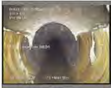
Foto: S_1_8_28022021_090945_A.JPG 47,1m, Fin de la inspección
