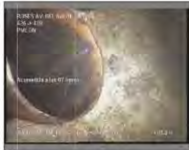
Foto: 1_1_13_23022021_091230_A.JPG 60,9m, Acometida a las 07 horas
