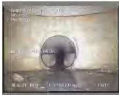
Foto: 13_1_9_18022021_110706_A.JPG 43,4m, Fin de la inspección
