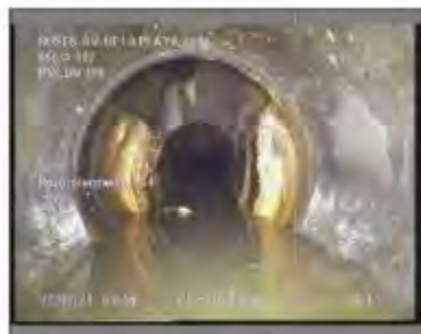
Foto: 26_1_4_22022021_093826_A.JPG 30,4m, Pozo Intermedio
