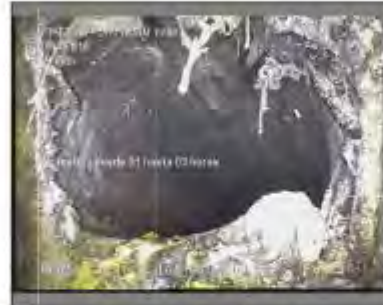
Foto: 1_1_3_18022021_104338_B.JPG 14,3m, Acometida desde 01 hasta 03 horas
