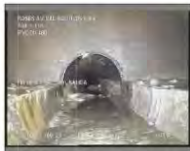
Foto: 4_1_9_24022021_092528_A.JPG 52,7m, Fin de la inspección
