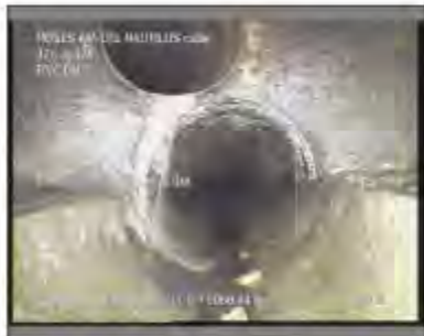
Foto: 1_1_14_23022021_091255_A.JPG 60,9m, Fin de la Inspección
