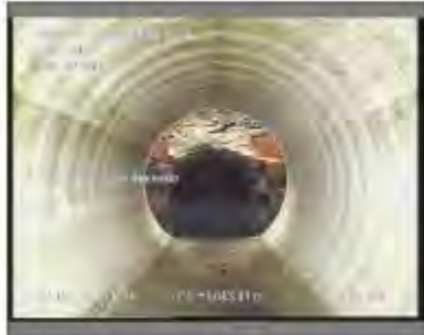
Foto: 28_1_6_22022021_113647_A.JPG 44,2m, Llegada al punto deseado
