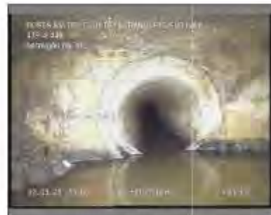
Foto: 18_1_13_02032021_110820_A.JPG 77,1m, Fin de la inspección
