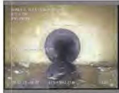
Foto: 22_1_8_22022021_082521_A.JPG 47,1m, Fin de la inspección
