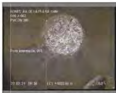
Foto: 26_1_4_22022021_093840_B.JPG 30,4m, Pozo Intermedio
