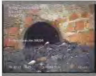
Foto: 18_1_7_19022021_143651_A.JPG 58,3m, Fin de la inspección
