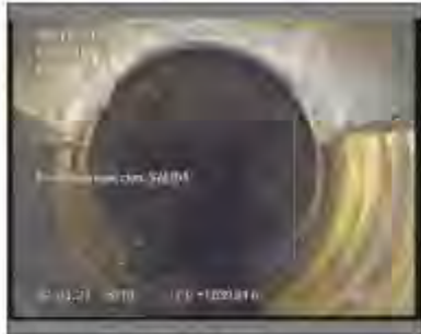
Foto: 24_1_7_02032021_162049_A.JPG 39,9m, Fin de la inspección
