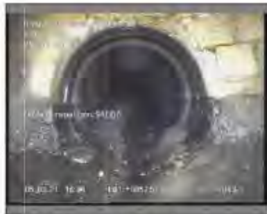
Foto: 52_1_7_05032021_162354_A.JPG 52,5m, Fin de la Inspección
