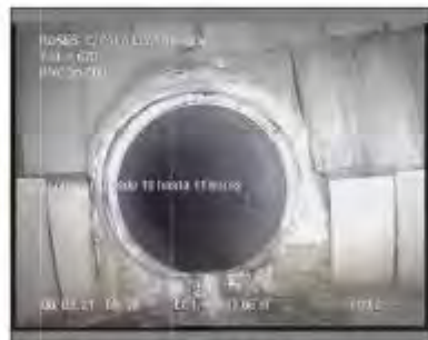
Foto: SE_1_4_08032021_094049_A.JPG 49m, Acometida desde 10 hasta 11 horas
