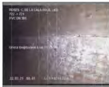
Figura 46: Fissura longitudinal entre els pous de registre 722 - 721
