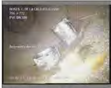
Foto: 23_1_A_22022021_083130_A.JPG 45,1m, Acometida desde 04 hasta 06 horas
