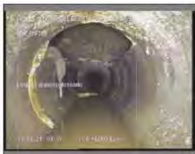
Foto: 10_1_4_26022021_093936_A.JPG 51,2m, Llegada al punto deseado
