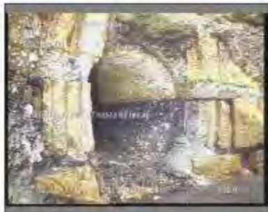
Foto: 28_1_7_22022021_113721_A.JPG 44,2m, Acometida desde 07 hasta 08 horas
