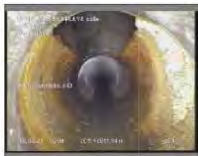
Foto: 21_1_3_18022021_160052_A.JPG 11,7m, Pozo Intermedio
