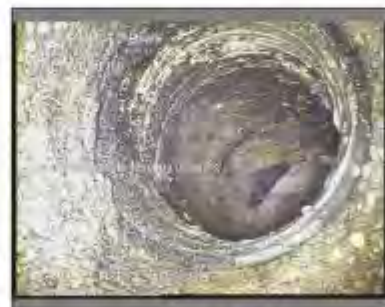
Foto: 43_1_7_24022021_114953_B.JPG 37,8m, Acometida desde 12 hasta 02 horas
