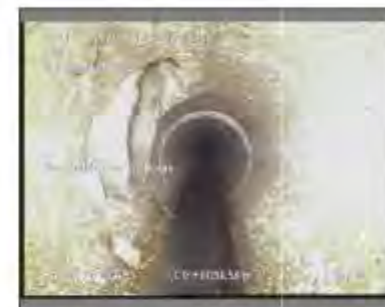
Foto: 40_1_7_23022021_125540_A.JPG 35m, Acometida a las 09 horas
