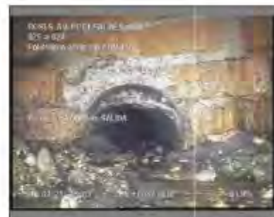
Foto: 19_1_14_18022021_150553_A.JPG 37m, Fin de la inspección
