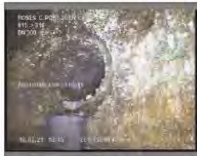
Foto: 1_1_8_16022021_104752_A.JPG 48,4m, Acometida a las 03 horas
