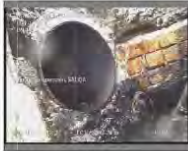
Foto: 46_1_7_03032021_133928_A.JPG 47,2m, Fin de la Inspección
