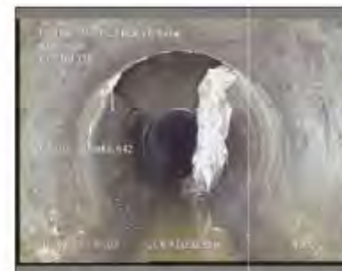
Foto: 21_1_6_18022021_160436_A.JPG 38,9m, Pozo Intermedio
