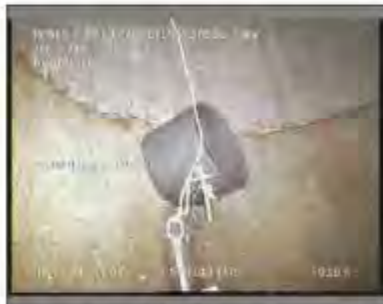
Foto: 13_1_S_18022021_110653_A.JPG 43,4m, Acometida a las 05 horas
