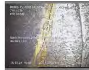
Figura 48: Fissura longitudinal entre els pous de registre 719 - 715
