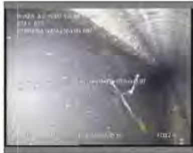
Foto: 7_1_3_16022021_145435_B.JPG 3,3m. Obstáculo por sedimentaciones desde 06 hasta 07 horas. Reducción de sección 0 %
