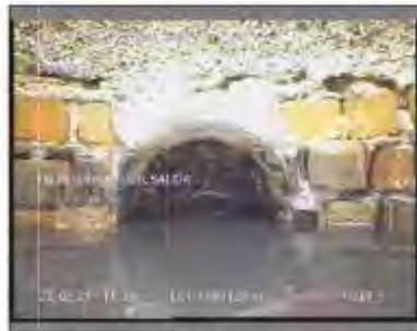
Foto: 28_1_8_22022021_113806_A.JPG 44,2m, Fin de la inspección
