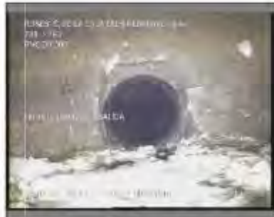
Foto: 14_1_6_18022021_111330_A.JPG 53,1m, Fin de la Inspección
