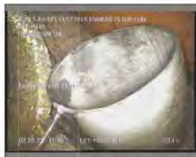
Foto: 18_1_6_02032021_110236_A.JPG 32,3m, Acometida a las 03 horas
