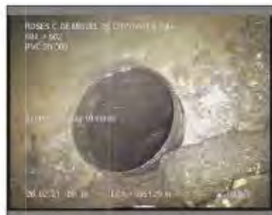
Foto: 10_1_7_26022021_094107_A.JPG 51,2m, Acometida a las 10 horas
