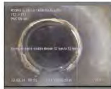
Figura 46: Fissura longitudinal entre els pous de registre 722 - 721
