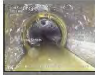
Foto: 1_1_E_18022021_104811_A.JPG 25,1m, Acometida desde 12 hasta 02 horas
