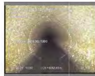
Foto: 18_1_7_02032021_110447_A.JPG 52,8m, Comentario
