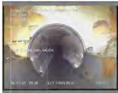
Foto: 21_1_6_02032021_133034_A.JPG 41m, Fin de la Inspección
