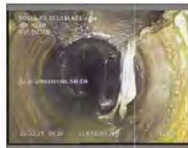
Foto: 25_1_13_22022021_092855_A.JPG 57,3m, Fin de la inspección
