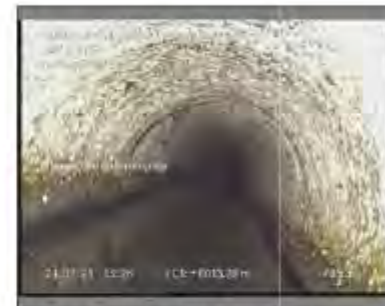
Foto: 45_1_4_24022021_132906_B.JPG 13.2m, Inspección interrumpida
