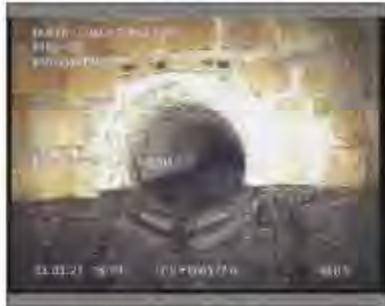
Foto: 47_f_1_b_03032021_163220_A.JPG 63,7m, Fin de la inspección
