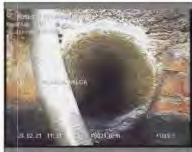
Foto: 42_1_8_24022021_113327_A.JPG 33,7m, Fin de la inspección
