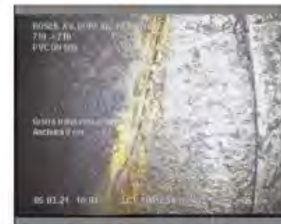
Figura 8: Fieura longitudinal. Tram Inspecció 53 entre els pous 719 i 718
