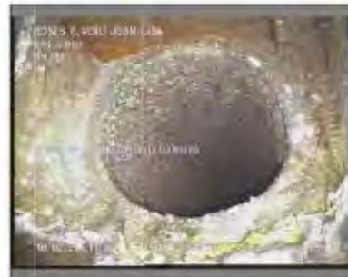
Foto: 2_1_2_18022021_110854_B.JPG 7,6m, Acometida desde 01 hasta 03 horas
