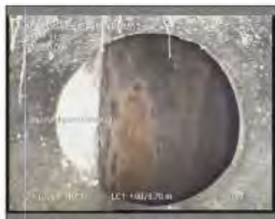
Foto: T_1_8_24022021_104910_A.JPG 79,2m, Llegada al punto deseado
