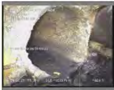
Foto: 42_1_7_24022021_113306_A.JPG 33,7m, Acometida a las 08 horas
