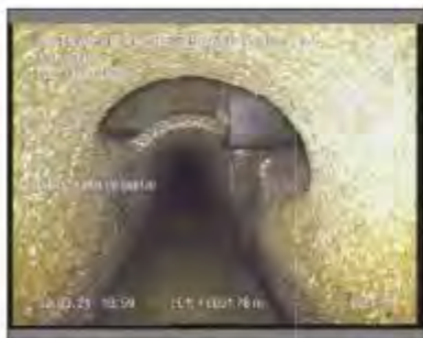
Foto: 18_1_5_02032021_110211_A.JPG 32,3m, Pozo oculto (arqueta)
