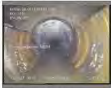
Foto: 26_1_16_22022021_095018_A.JPG 71m, Fin de la inspección
