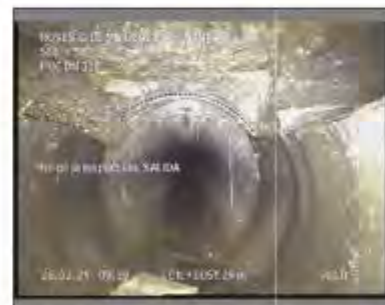
Foto: 10_1_8_26022021_094128_A.JPG 51,2m, Fin de la inspección
