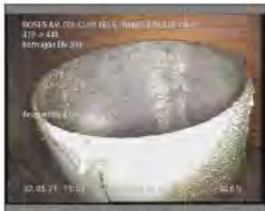
Foto: 18_1_9_02032021_110637_A.JPG 56,4m, Acometida a las 03 horas
