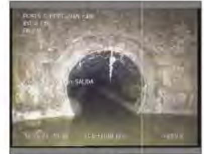
Foto: 1_1_11_16022021_104836_A.JPG 48,4m, Fin de la inspección
