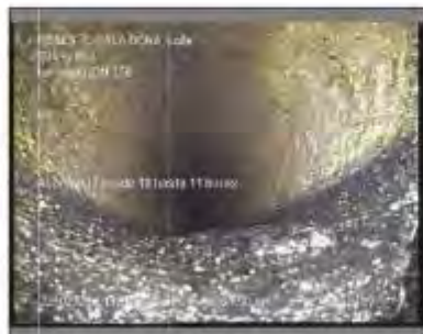
Foto: 28_1_2_22022021_111315_B.JPG 1,5m, Acometida desde 10 hasta 11 horas
