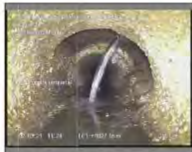
Foto: 19_1_4_02032021_112705_A.JPG 27,6m, Pozo oculto (arqueta)
