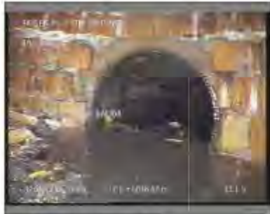
Foto: 88_1_A_12032021_100828_A.JPG 16.5m, Fin de la inspección
