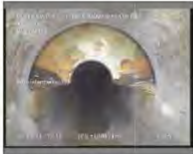
Foto: 21_1_6_02032021_121359_A.JPG 40,9m, Llegada al punto deseado
