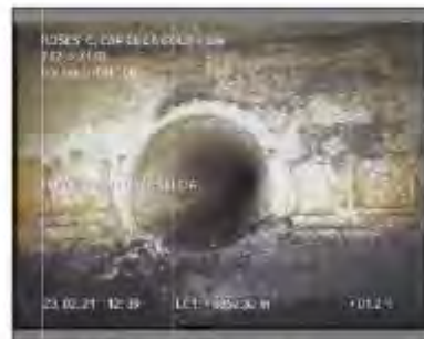
Foto: 38_1_8_23022021_124221_A.JPG 52,3m, Fin de la Inspección
