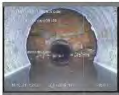
Foto: 19_1_12_18022021_150503_A.JPG 37m, Llegada al punto deseado
