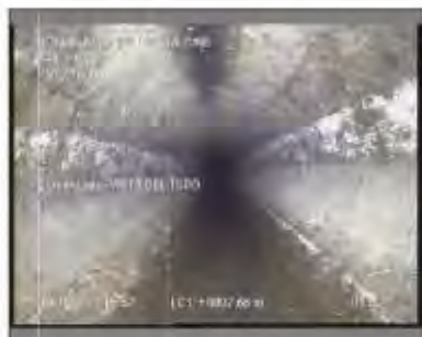
Foto: 21_1_2_18022021_160012_A.JPG 7,6m, Comentario
