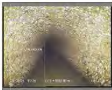
Foto: 36_1_1_23022021_112915_B.JPG 0m, Inicio de la inspección
