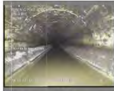
Foto: 2_1_1_18022021_110724_B.JPG 0m, Inicio de la inspección
