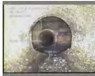
Foto: 38_1_7_23022021_124136_A.JPG 52,3m, Llegada al punto deseado
