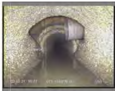
Foto: 19_1_2_02032021_112647_A.JPG 17,7m, Pozo oculto (arqueta)
