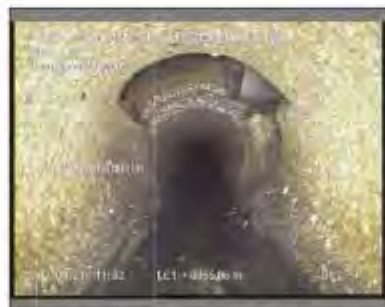
Foto: 18_1_8_02032021_110516_A.JPG 56,4m, Pozo oculto (arqueta)
