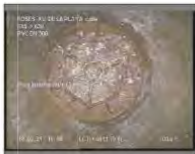
Foto: 21_1_3_18022021_160108_B.JPG 11,7m, Pozo Intermedio
