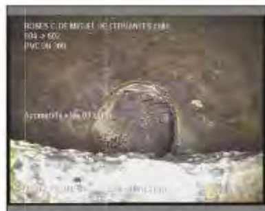
Foto: 10_1_5_26022021_094026_A.JPG 51,2m, Acometida a las 03 horas
