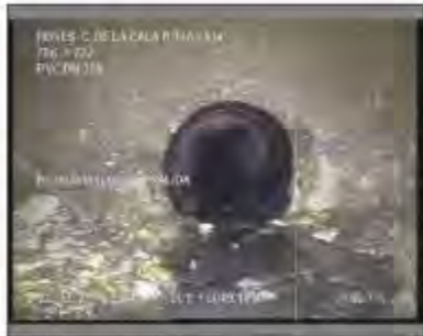
Foto: 23_1_G_22022021_083204_A.JPG 45,1m, Fin de la Inspección
