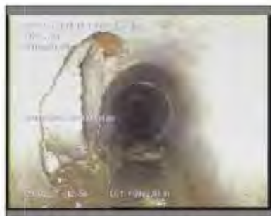
Foto: 40_1_10_23022021_125640_A.JPG 61,3m, Acometida a las 09 horas
