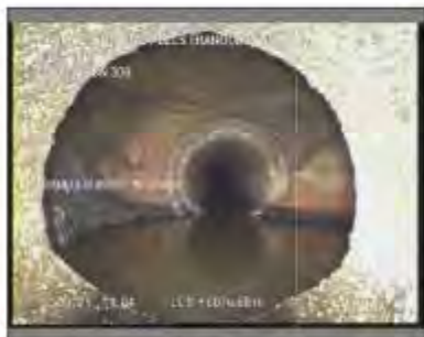
Foto: 18_1_11_02032021_110722_A.JPG 77,1m, Llegada al punto deseado
