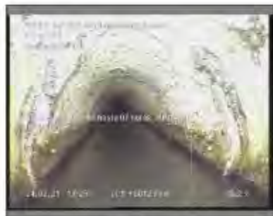
Foto: 45_1_3_24022021_132820_A.JPG 12.6m, Obstáculo desde 06 hasta 07 horas
