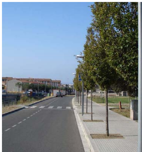
Foto 5. La riera de Ginjolers presenta l'espai viari dividit entre vorera i calçada en el seu tram superior
