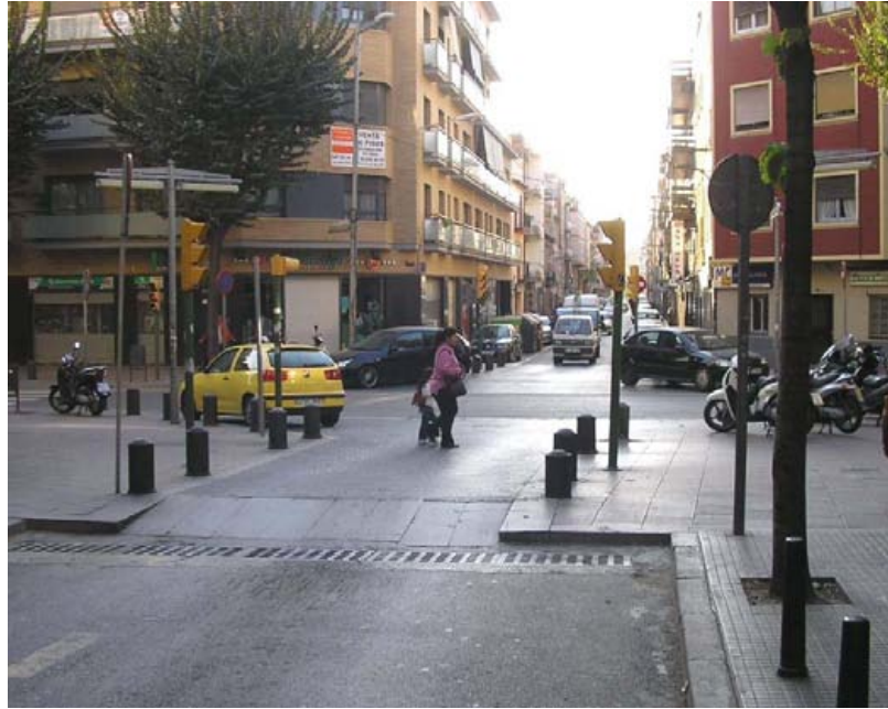
Vorera elevada configurant una entrada a una zona 30
