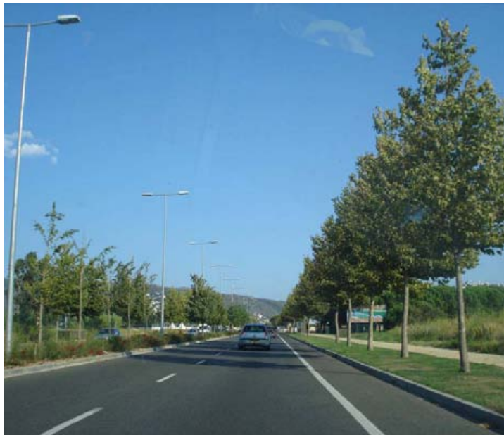
Foto 4. Carretera C-260 a la seva entrada a Roses
