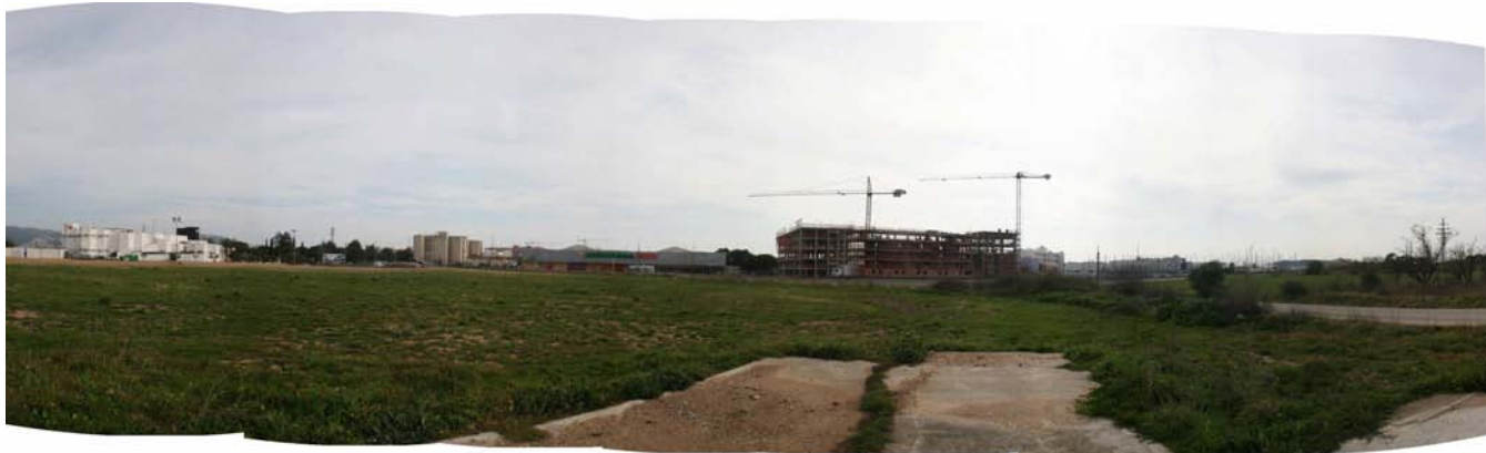
Imatge 59 – Vista de la façana de la carretera de Figueres
