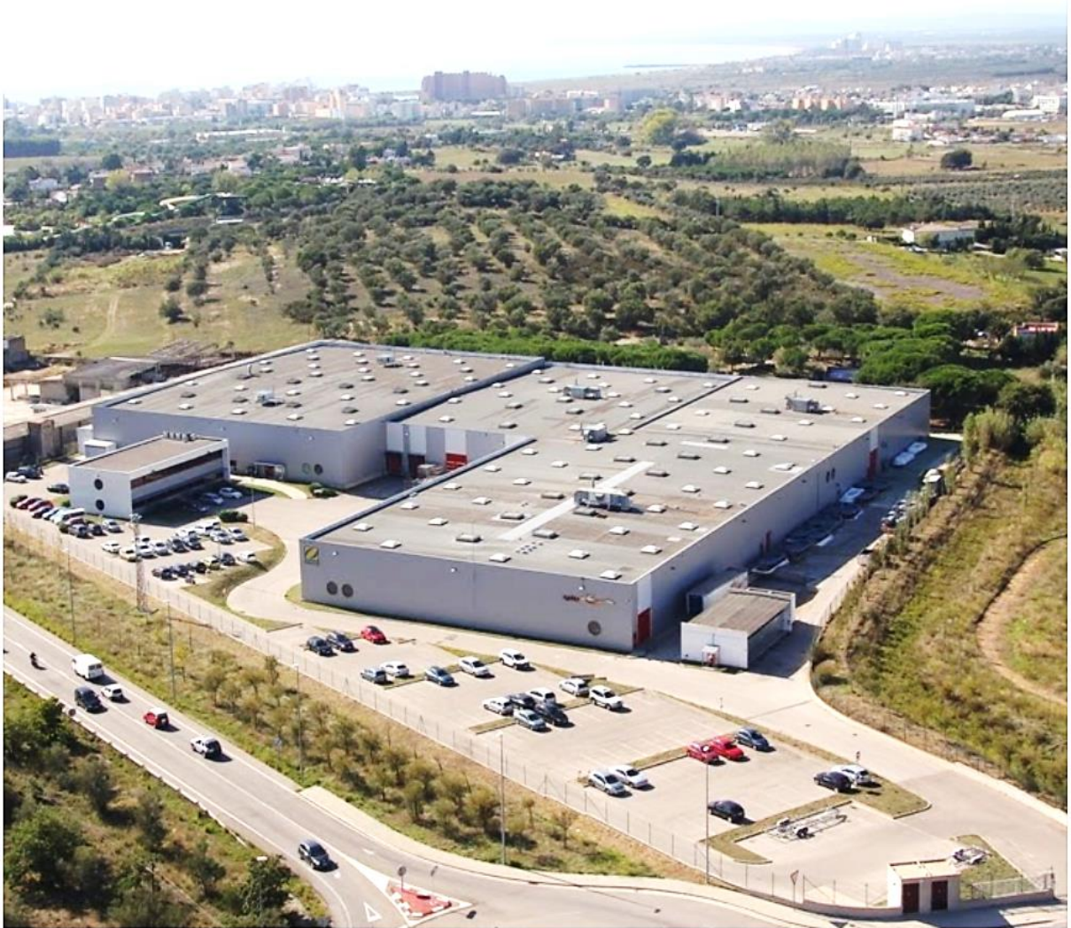
URBANITZACIÓ COMPLETA A LA PART NORD DE L'ÀMBIT
