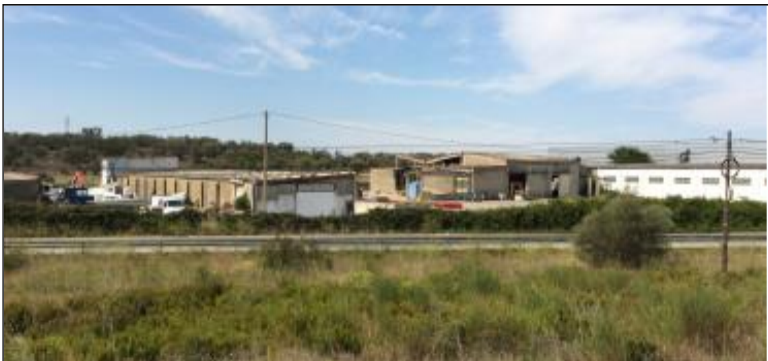
Imatge de la nau situada al sud de la parcel·la
