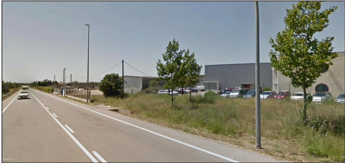
Situació actual. Vistes des de la carretera de Vilajuïga
