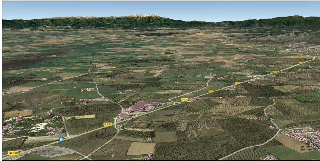
Vistes de l'actual zona industrial inclosa a l'àmbit del Pla i les diferents construccions actualment presents
