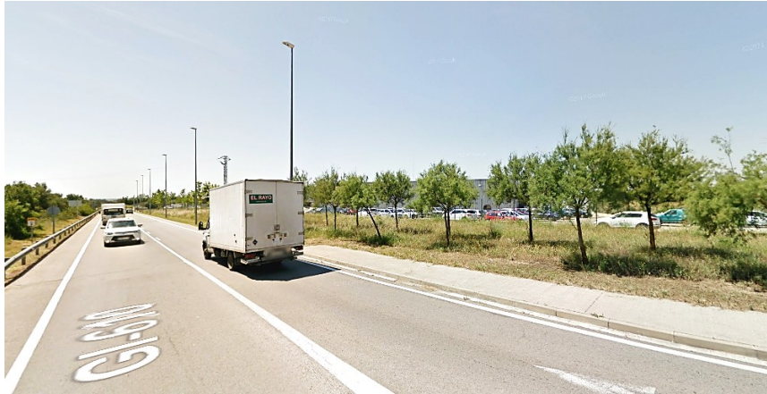
Carretera de Vilajuïga
