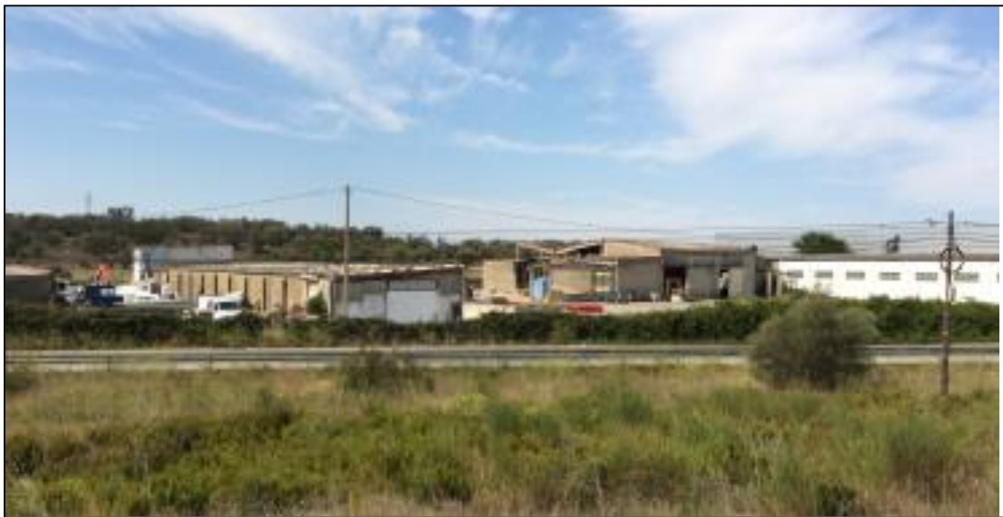
Imatge de la nau situada al sud de la parcel·la
