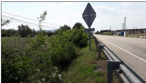
Vista aigua avall de la riera des del marge esquerre de la carretera
