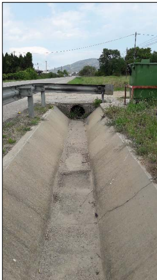
Vista aigua amunt de la riera del Mas Just i de l'obra de drenatge d'accés al Mas d'en Just des del marge esquerre de la carretera GI-610
