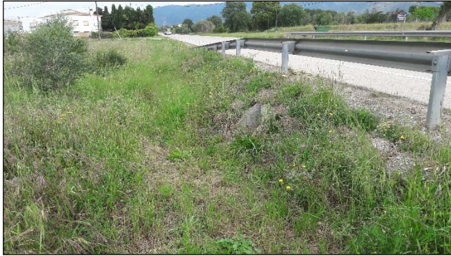
Vista aigua amunt de la riera del Mas Just des del marge dret de la carretera GI-610
