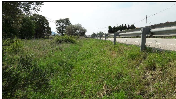
Vista aigua avall de la riera des del marge esquerre de la carretera.
