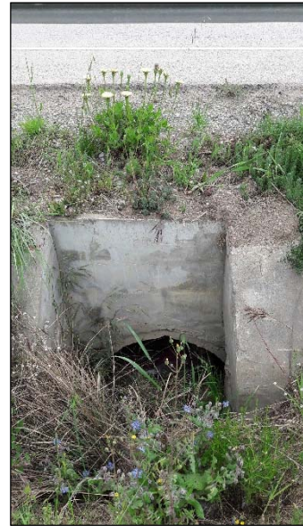
Vista aigua amunt de l'obra de drenatge que travessa la carretera GI-610
