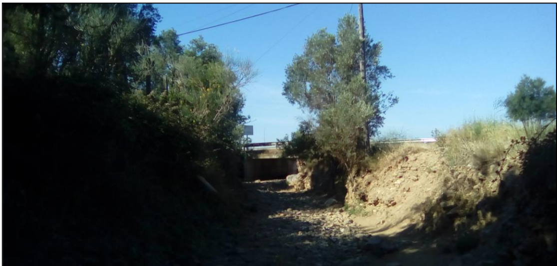
Imatge del situat aigües amunt del pont de la carretera de Vilajuíga
