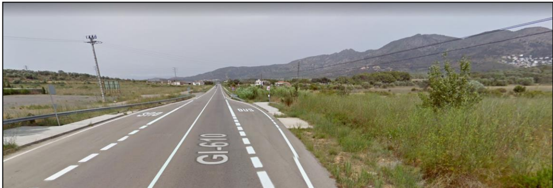
Vistes del sector sud del Pla des de la carretera de Vilajuïga
