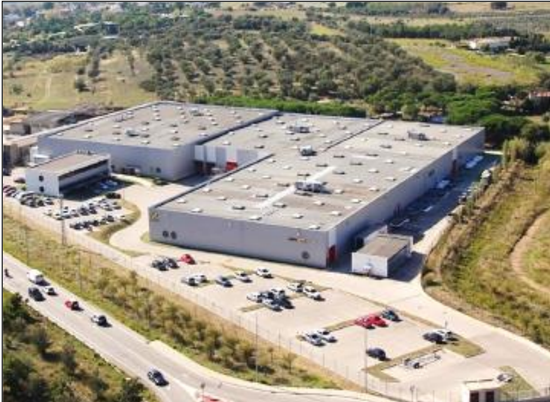
Imatge de la nau situada al nord de la parcel·la
