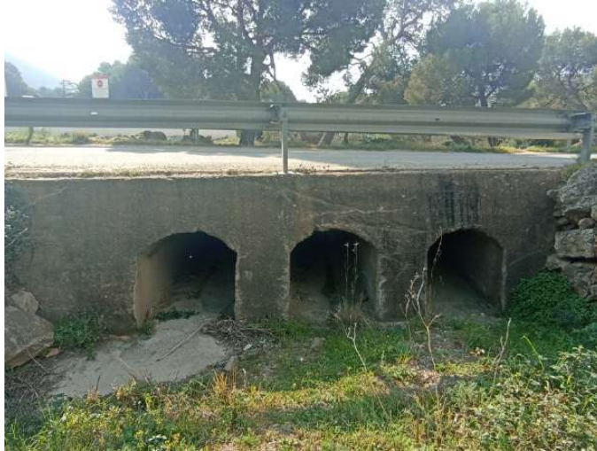
Imatge 17. Fotografies estructures hidràuliques del rec de Montjoi
