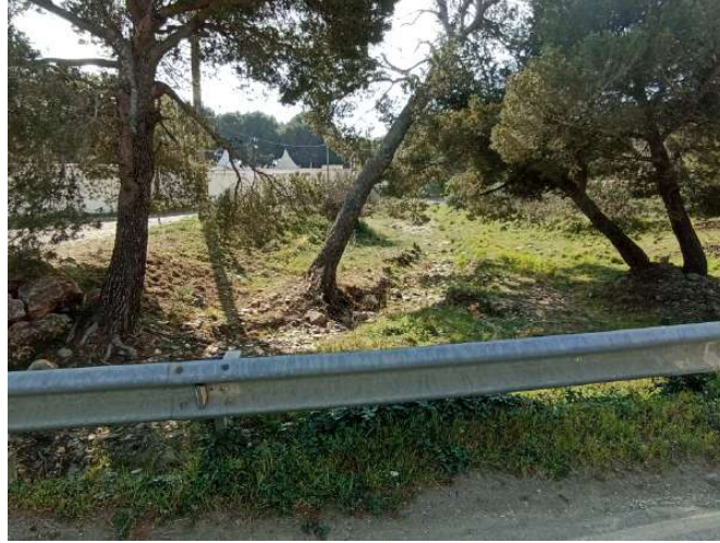
Imatge 9. Vista del rec aigües avall on es pot observar el mur perimetral del càmping ciutat de Vacances i del Bullifoundation
