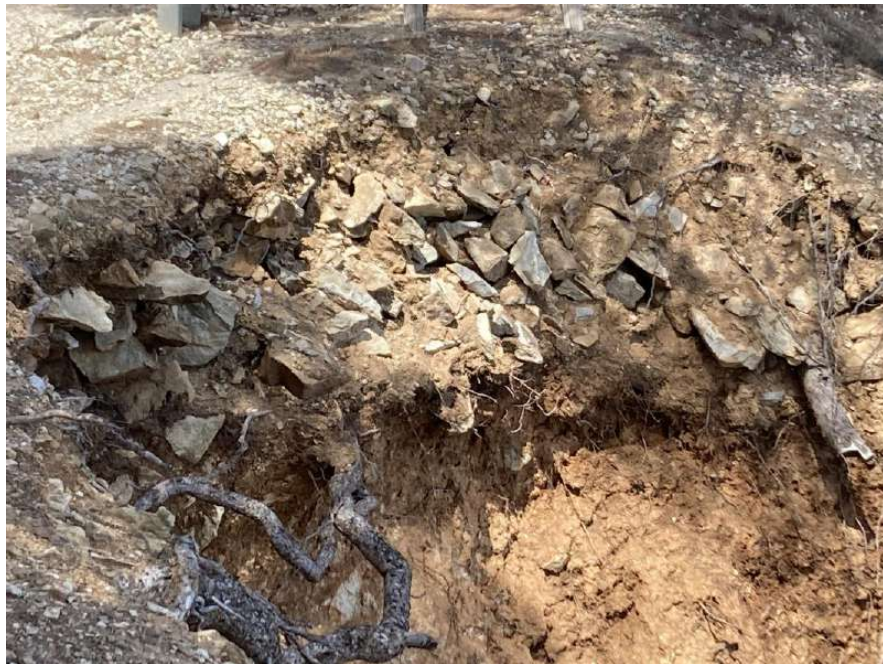
Fotografia 1: Materials aportats. Blocs de graves cantelludes decimètriques de subbase de la carretera.
