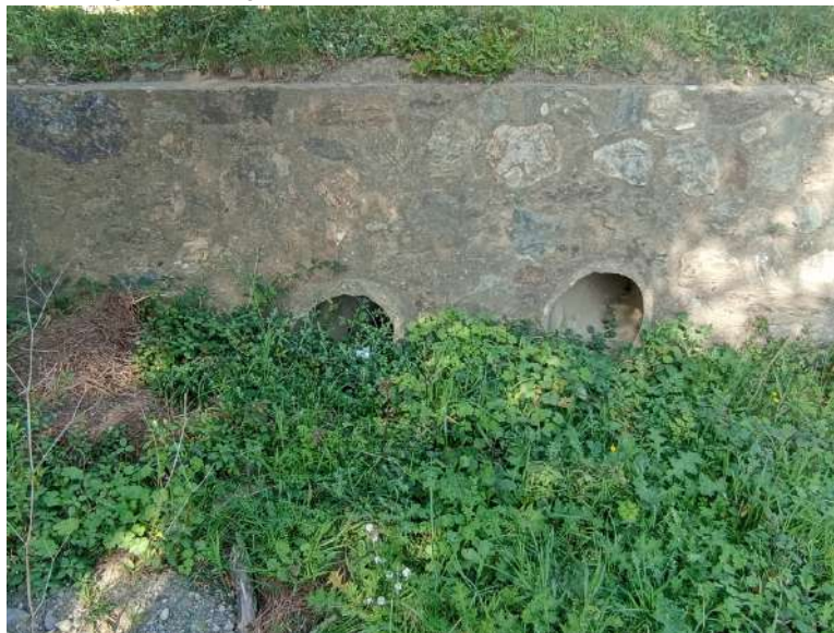
Imatge 18. Fotografies estructures hidràuliques escòrrec lateral
