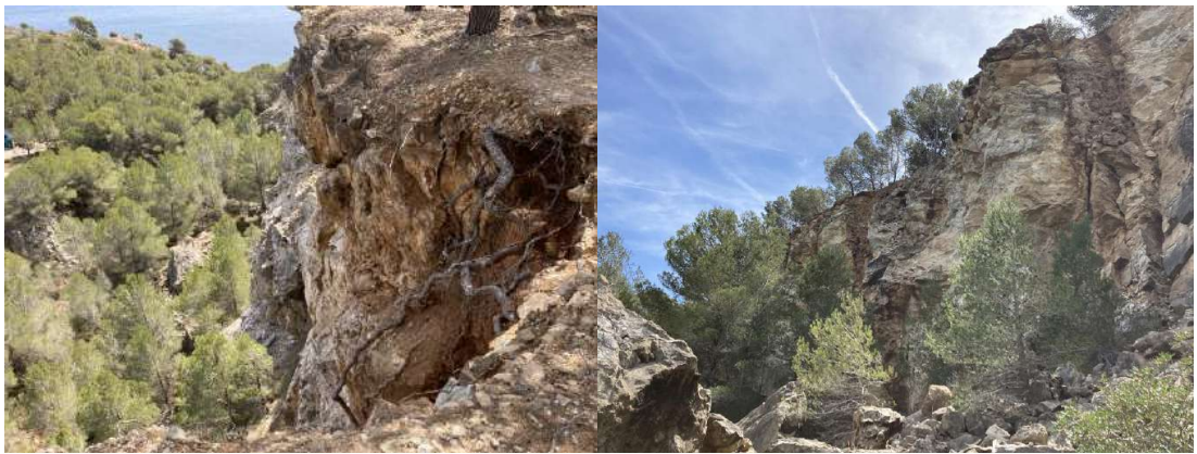
Fotografies 2: Materials argilosos i sauló a l'indret després. Aspecte de la presència vertical de les cavitats càrstiques al llarg del front d'explotació de la pedrera.
