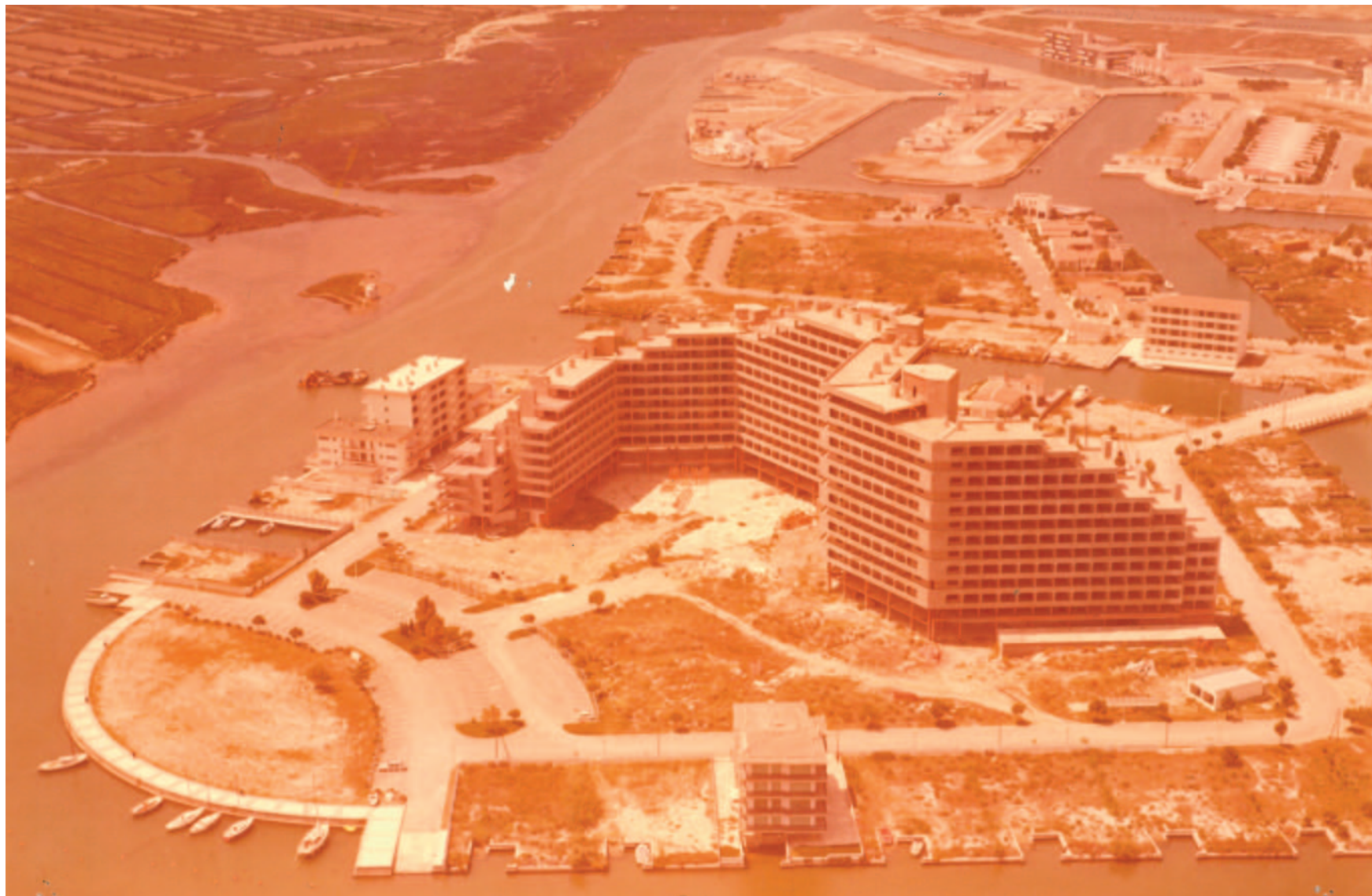
| AMR. Fons Risques i Associats. Vista aèria de l'edifici 600 i el seu entorn. ca. 1975.
