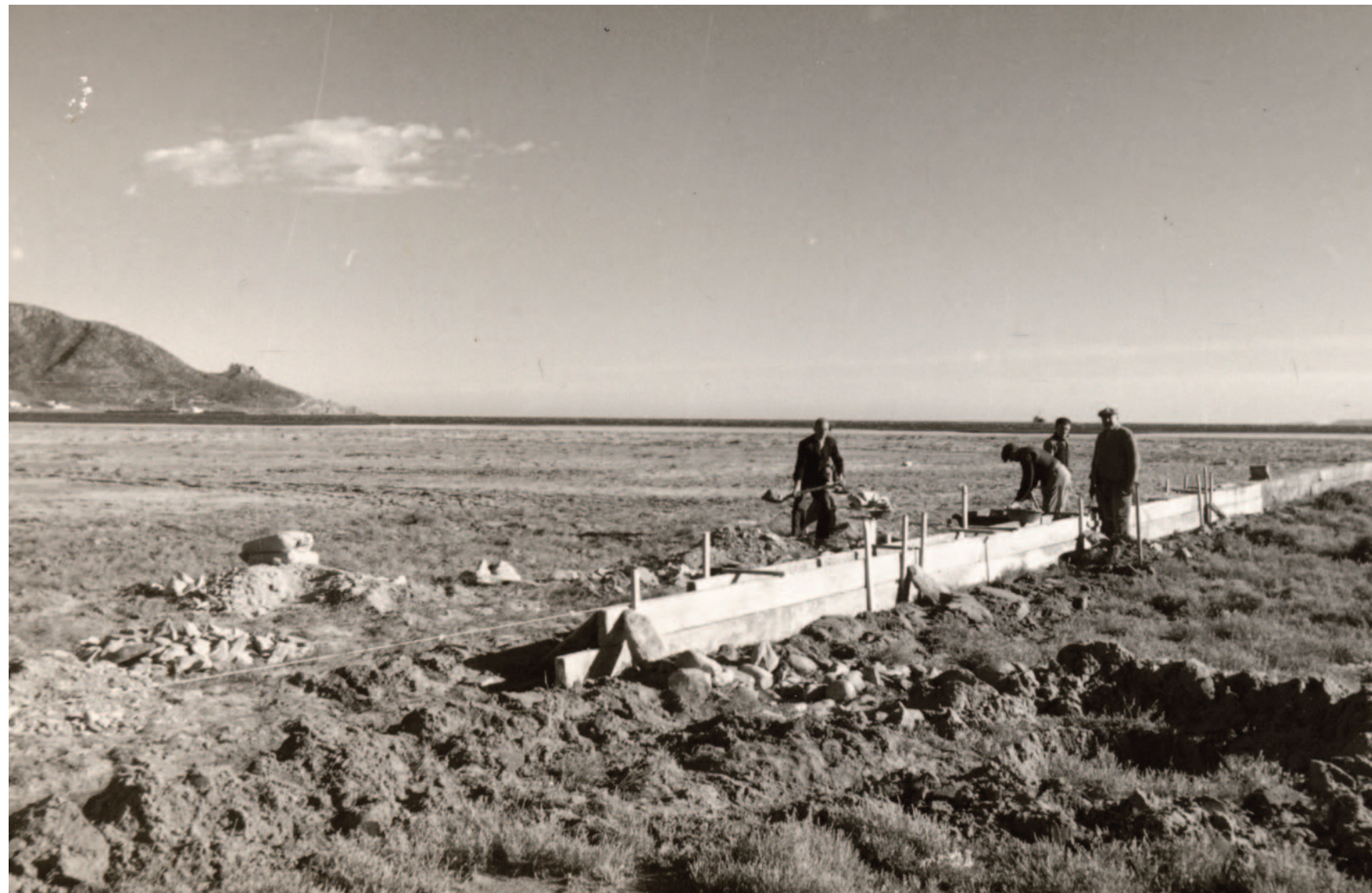
| AMR. Col·lecció Anna Maria Puig. Obrers treballant en l'obertura dels carrers de la urbanització de Santa Margarida. ca. 1960.
